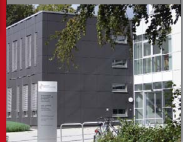
Bildungszentrum des Städtischen Krankenhauses Kiel
