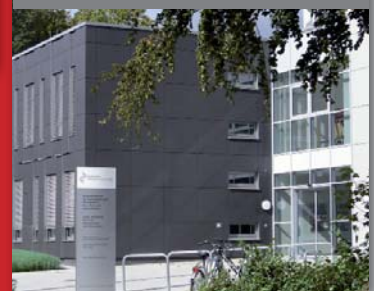
Bildungszentrum des Städtischen Krankenhauses Kiel
