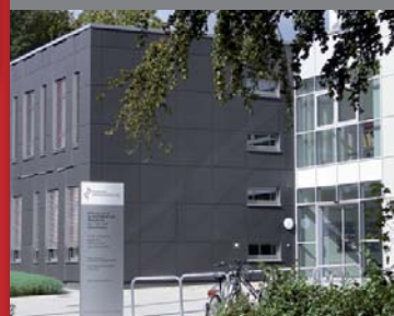
Bildungszentrum d. Städtischen Krankenhauses Kiel
