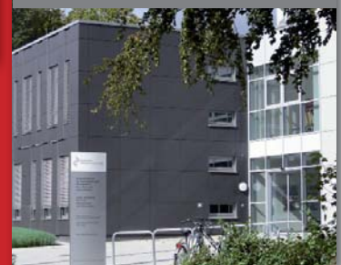
Bildungszentrum des Städtischen Krankenhauses Kiel
