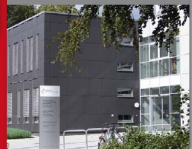
Bildungszentrum des Städtischen Krankenhauses Kiel
