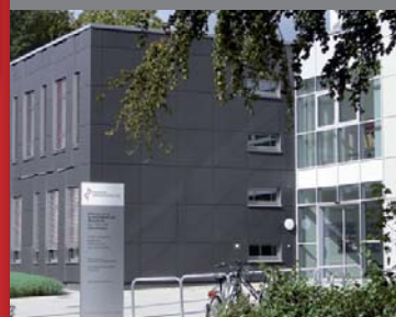
Bildungszentrum d. Städtischen Krankenhauses Kiel
